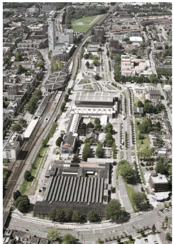
Luchtfoto spoorzone Tilburg Bron: SpoorzoneO13
